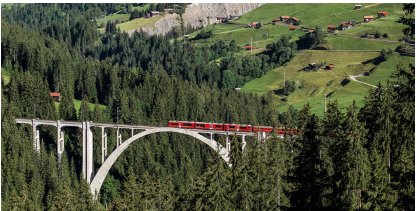
Imposanter Ausblick: Auf der Arosalinie überquert ein Zug den Langwieser Viadukt bei Langwies.
